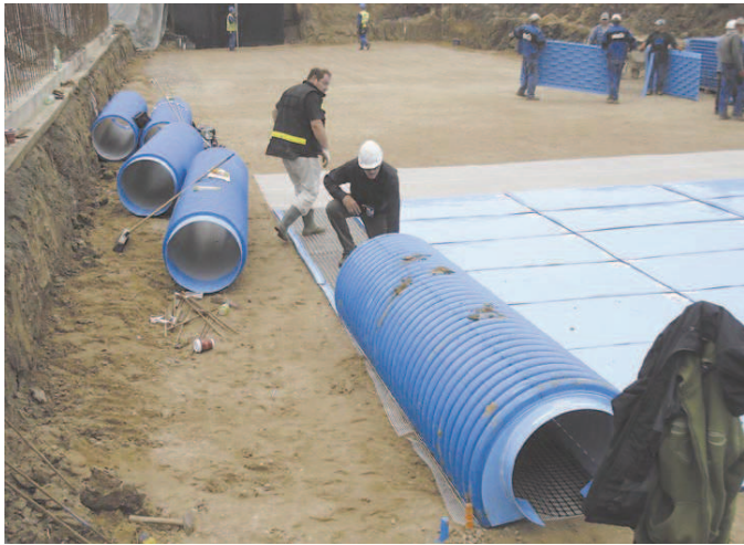
Montaż unikatowego wymiennika ciepła już trwa.
