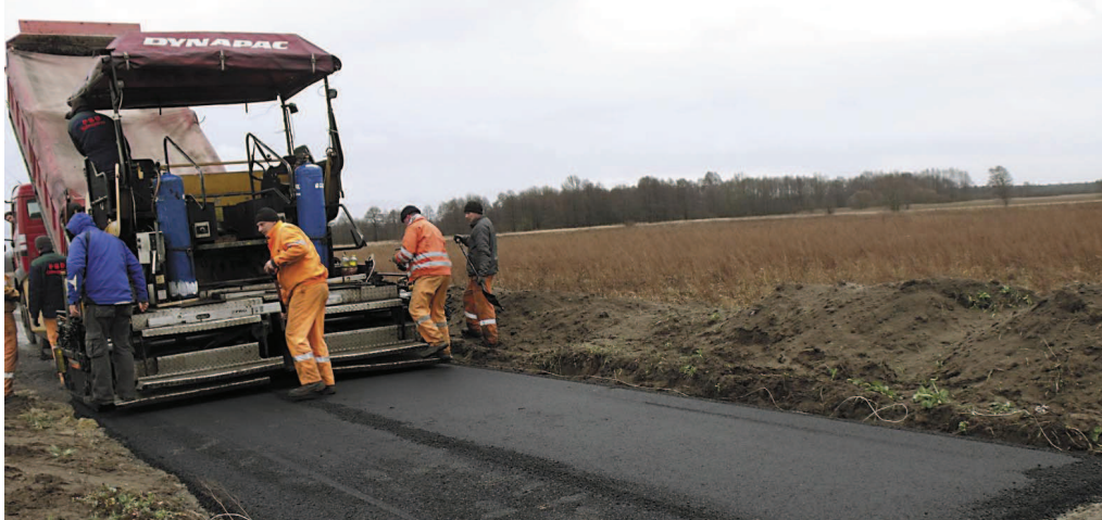
Najpierw firma Brukart z Jaczowa wykonała podbudowę drogi, potem ułożono na niej asfalt.
