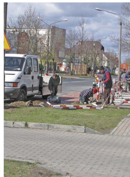
Prace przy budowie zatoki dobiegły końca. Na zdjęciu robotnicy podczas czynności końcowych.
