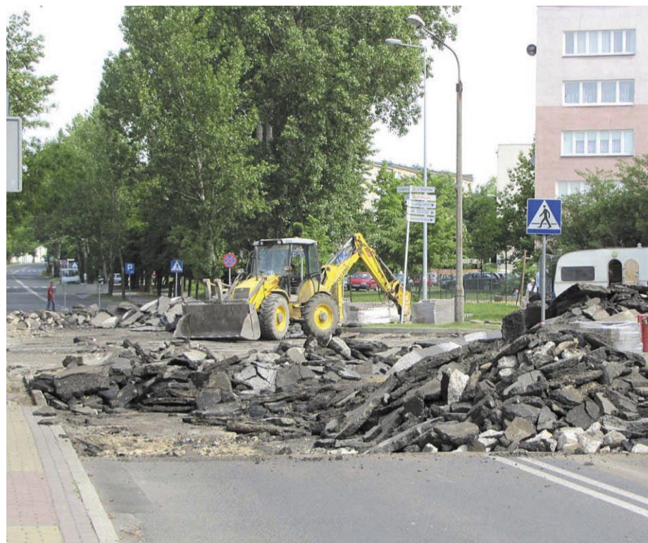
Prace, związane z budową ronda, mają potrwać 18 tygodni.
