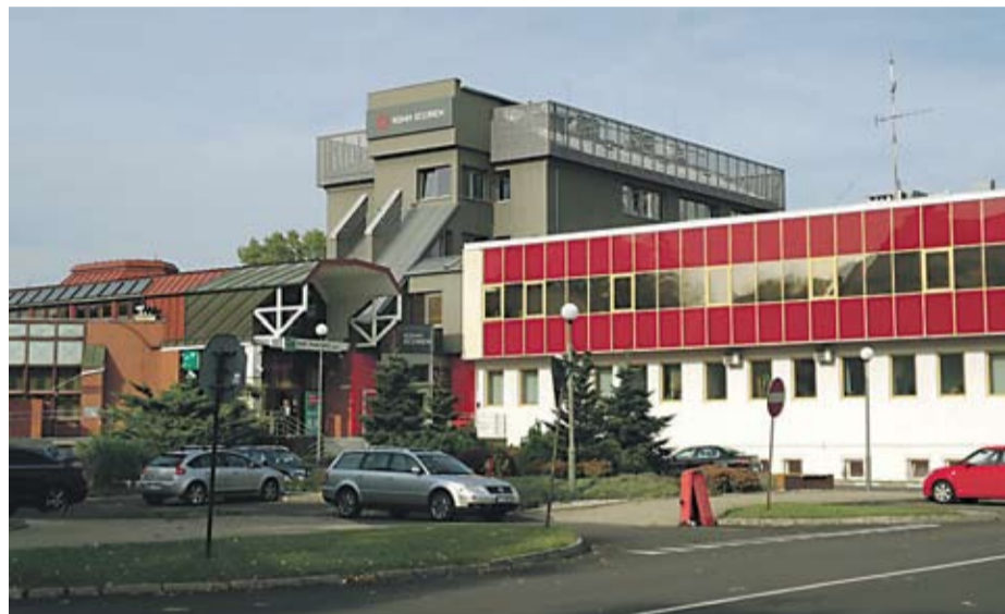
Budynek Ecorenu przy ul. Skłodowskiej-Curie w Lubinie dzięki nowemu lokatorowi zostanie wyremontowany.
