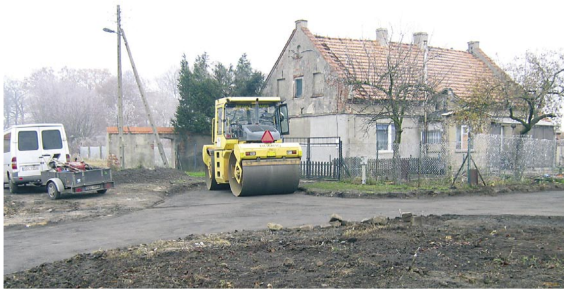
Remont drogi w Kotowicach.
