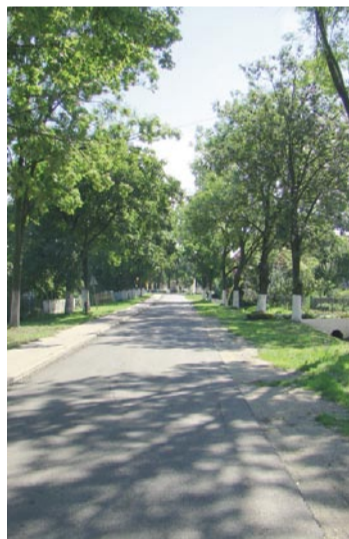
Jedną z inwestycji będzie przebudowa drogi w Rzeczycy.
