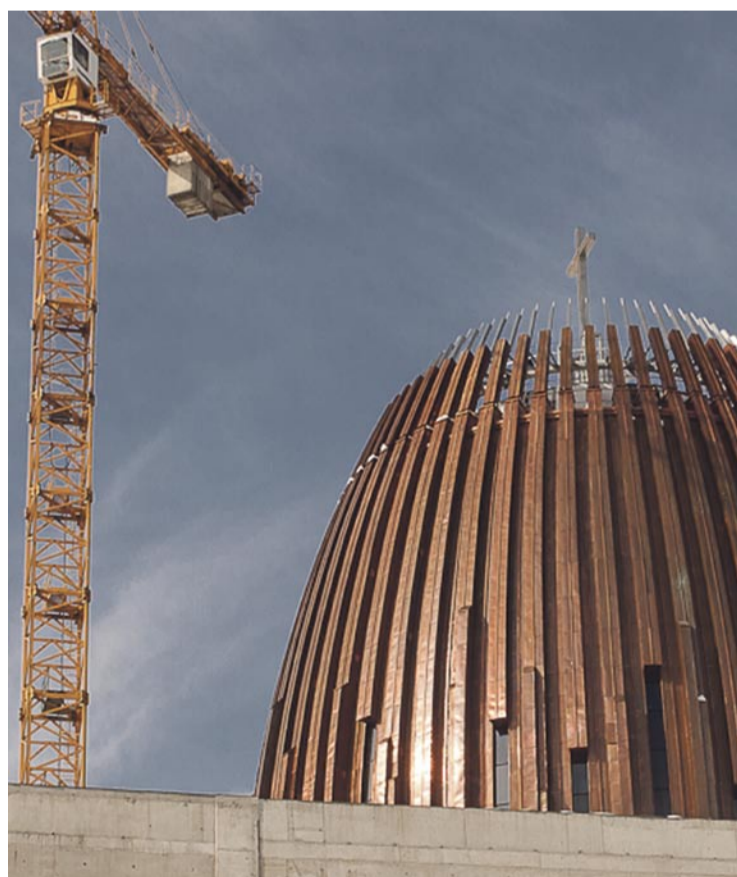
Miedziany dach może przetrwać nawet 700 lat. Tyle, że dzięki patynie zmieni kolor ze rdzawego na zielony.
