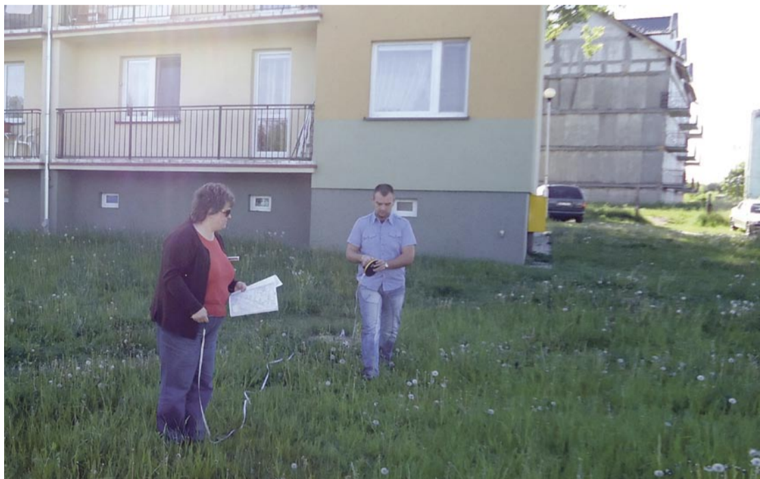
Projektanci porównują ustalenia geodetów z sytuacją na miejscu. Zanim naniosą PSZOK na mapę, dokonują pomiarów. Przyszły PSZOK nie może bowiem stać bliżej niż 10 metrów od budynków mieszkalnych.
