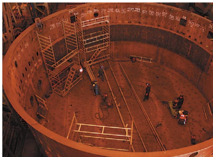
To już historyczne zdjęcie: montaż elementów nowego panczerza pieca elektrycznego.
