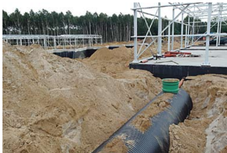
Teren budowy z perspektywy. Na pierwszym planie – zbiornik na nieczystości płynne, w tle – budynek magazynu na odpady niebezpieczne oraz wiata magazynowa i garażowa.
