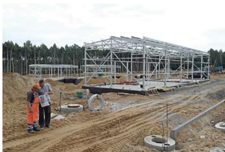
Trwa wytyczanie i budowa dróg wewnętrznych.
