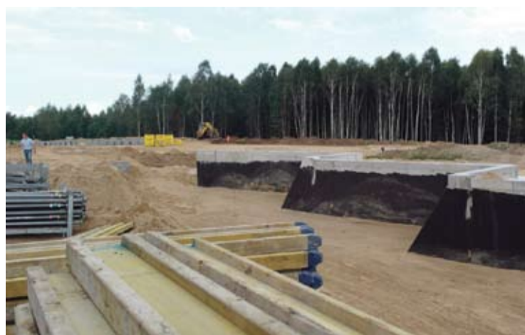
To część przyszłej rampy rozładunkowej. W tle widać plac na odpady zielone gdzie trwa tzw. zagęszczanie terenu.
