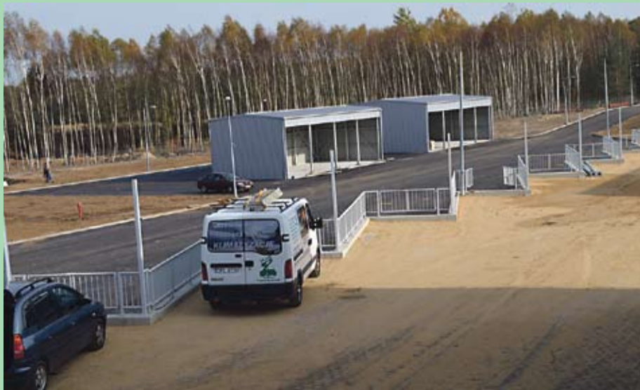
Rampa rozładunkowa. Z tego miejsca będziemy wrzucać do kontenerów ustawionych niżej, po drugiej stronie barierki, przywiezione odpady.
