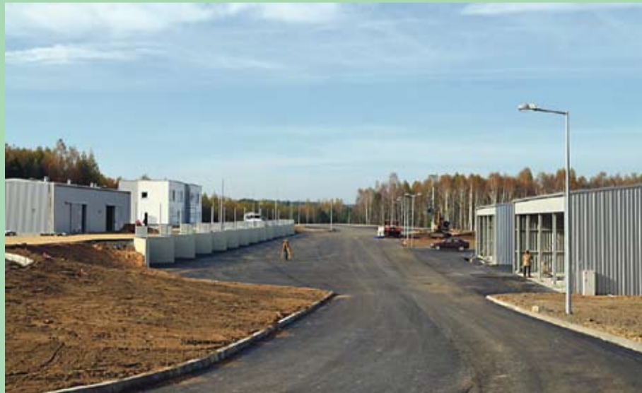
Widok ogólny. Po lewej, w tle, budynek administracyjno-biurowy, po prawej – dwa budynki magazynowe i garażowe.
