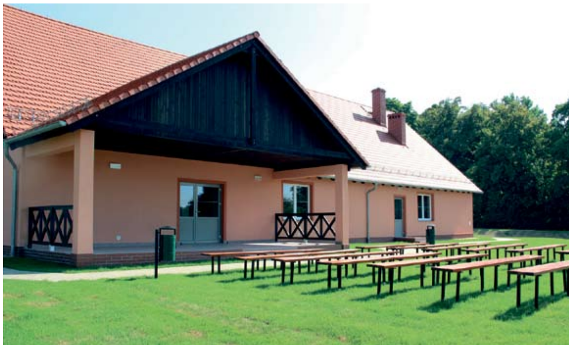
Nowa świetlica w Bądzowie.
