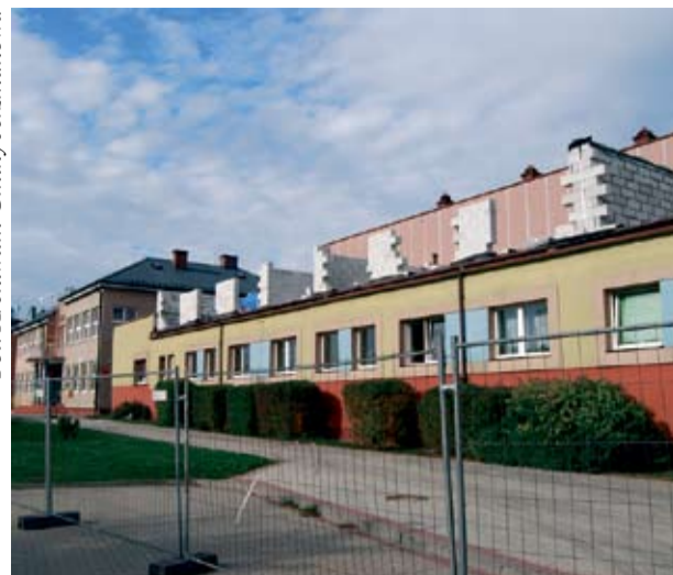
Trwająca rozbudowa SP w Jerzmanowej.
