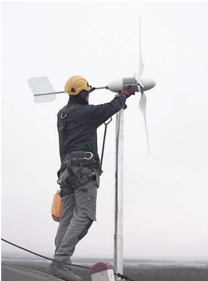
Zainstalowana na dużej wysokości turbina wiatrowa wytwarza energię, która zasila urządzenia radiowe, a jej nadmiar gromadzony jest w akumulatorach.
