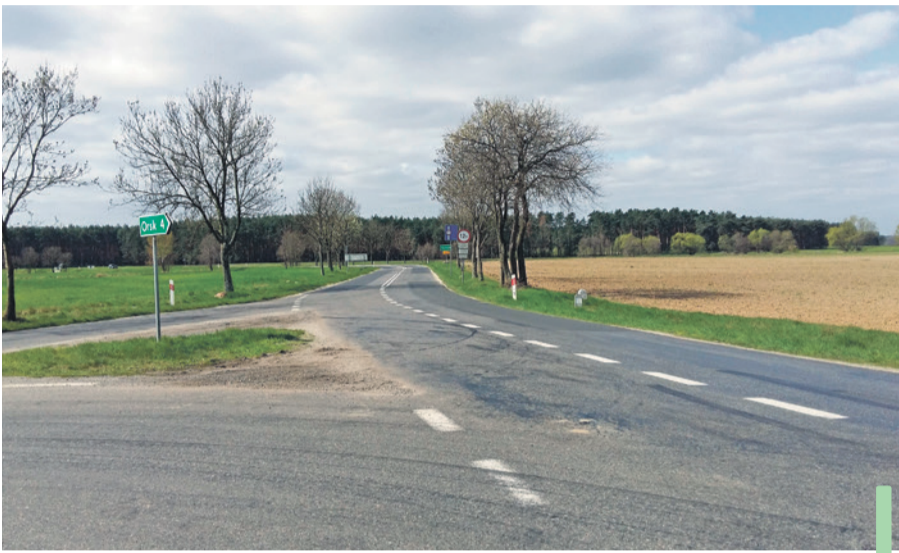
Przebudowana droga będzie składać się m.in. z dwupasmowej jezdni z poboczami i lewoskrętami.
