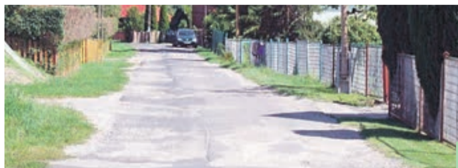
Na dofinansowanie inwestycji drogowych gminy mogą też liczyć w ramach Programu Rozwoju Obszarów Wiejskich. Zarząd województwa przeznaczył w ten sposób m.in. blisko 2 mln zł na przebudowę drogi w Maniowie (gm. Jerzmanowa).
